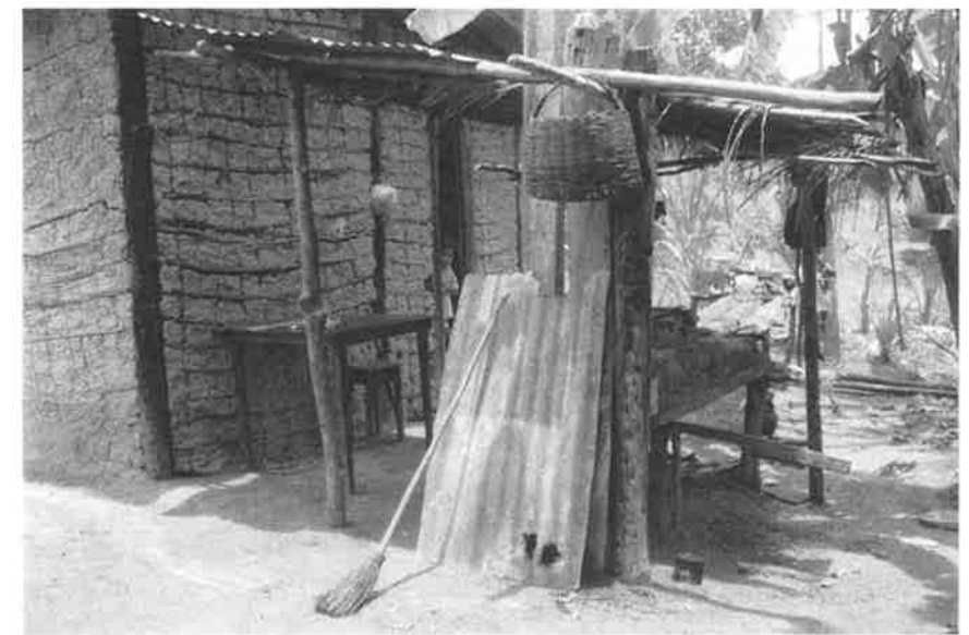
Figure 9.3 A nonplastered casa de sopapo or casa de taipa de mão . Bahia, Brazil, 1998. Photo: Susana de Matos Viegas
