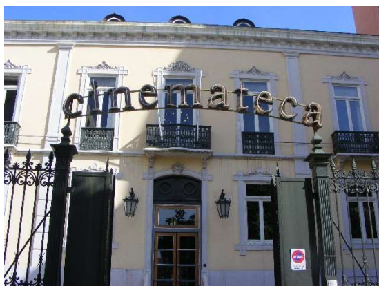
Fotos 103—104. Vista do exterior da Cinemateca.
