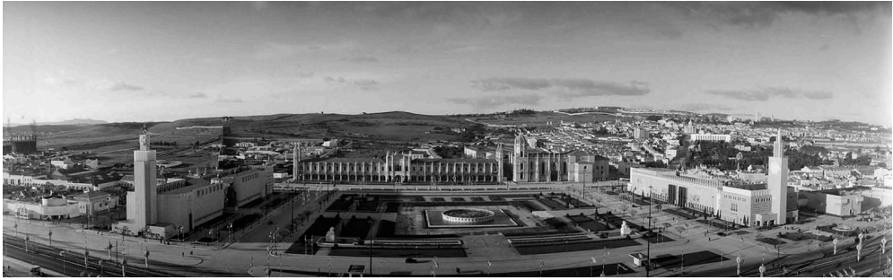
Figure 2. General view of EPW in 1940. Fundação Gulbenkian CFT164.163258 (Photo Estúdio Horácio Novais).
